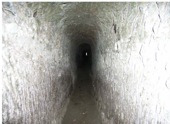
大多喜水道トンネル（二五隧道） 幅60cm(二尺)高さ1m50cm(五尺)
