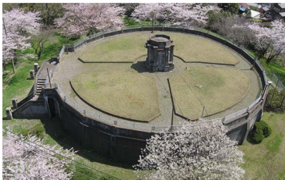
千葉県営水道千葉分場1号配水池
